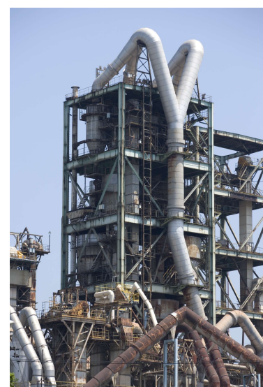
どうです、このパイプの群れ。近くで見ると相当な迫力です。
